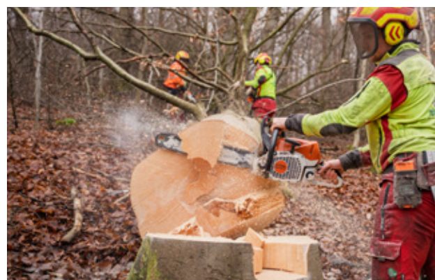
Baumfällungen zur Verkehrssicherung an der Kreisstraße 4576 im Februar 2026.
