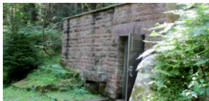
Eingang zum Quellsammelbauwerk
