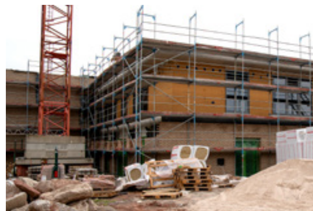
Außendämmung/ Klinkerfassade
