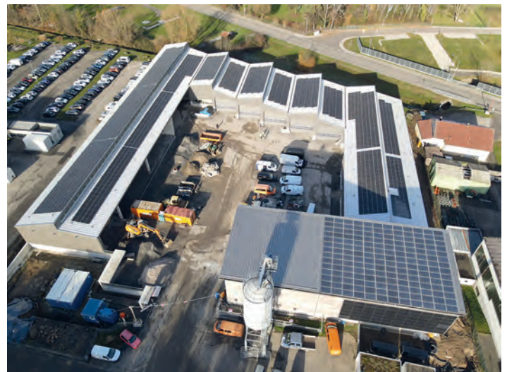
Beim kurz vor der Fertigstellung stehenden Ganzjahresstützpunkt der Enzkreis-Straßenmeisterei in Maulbronn sorgt eine große PV-Anlage mit Speicher dafür, dass der Stromverbrauch künftig aus eigener Produktion gedeckt werden kann. Das Vorzeigeprojekt wurde vom Bundesministerium für Wirtschaft und Energie gefördert.
