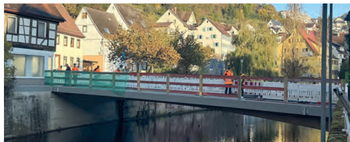
Sanierung der Hirschbrücke kurz vor Fertigstellung (Bildrechte: RPK)
