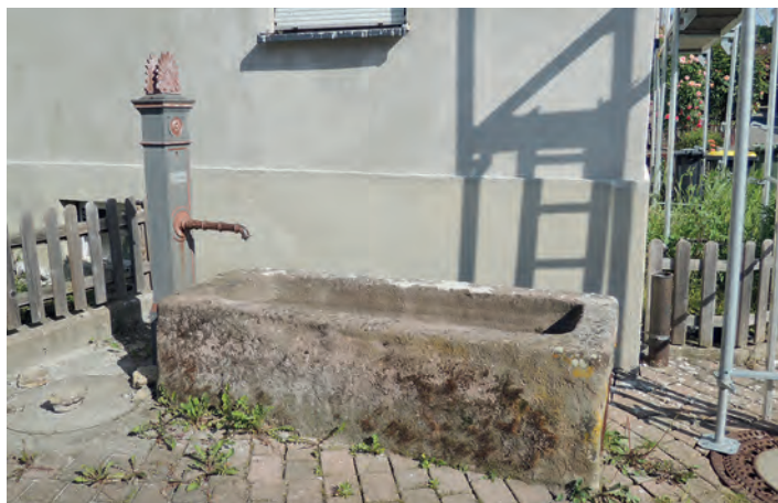
Der Brunnen am alten Standort in abgestelltem Zustand und in Mitleidenschaft gezogen.
