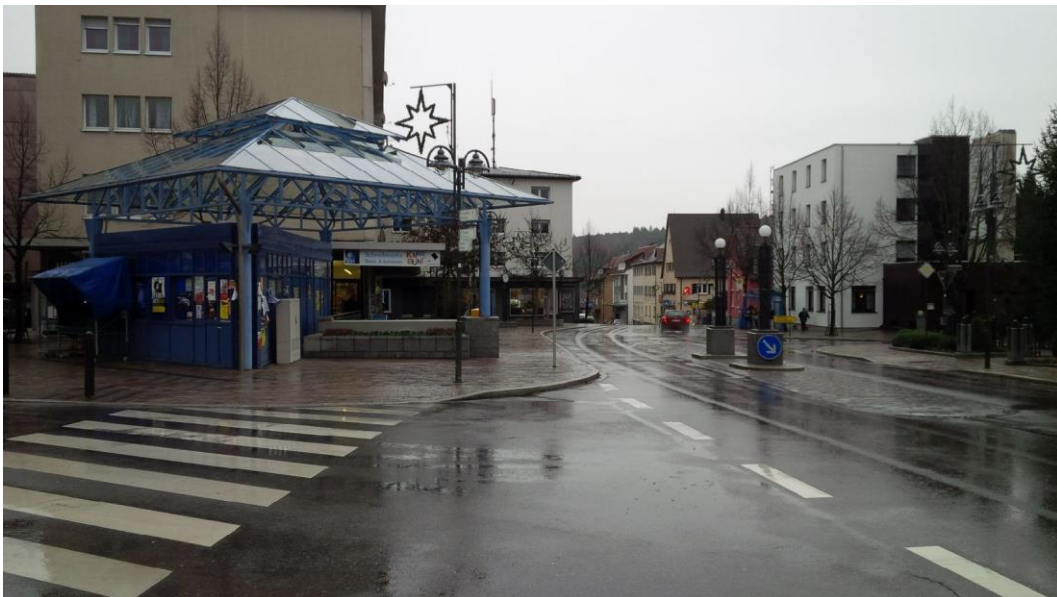
Kreuzungsbereich Hauptstraße / Baumgartenstraße: Konflikt Verkehrssicherheit, Lärmbelastung
