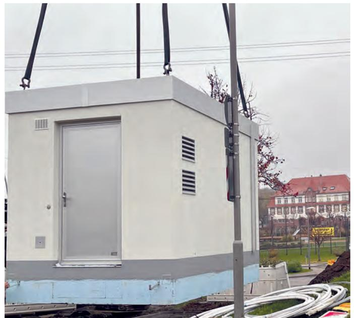
Das Foto zeigt die Aufstellung eines sog. PoP-Gebäudes in Gräfenhausen. (Bild: Tobias Kern, Zweckverband Breitbandversorgung im Enzkreis)
