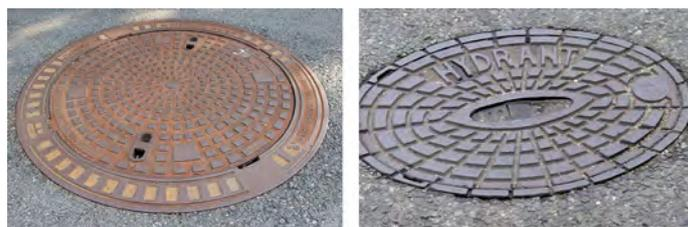
*Unterflurhydranten gibt es in zwei Varianten: **links** ein Schachthydrant, **rechts** ein Normhydrant. Während Normhydranten durch Form und Aufschrift recht gut zu erkennen sind, ist dies bei den Schachthydranten leider weniger eindeutig.*
