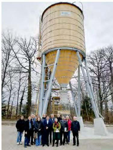
sogenannten Big Packs an diversen Standorten gelagert werden. Hierfür waren große Lagerflächen und Zeit für die Transportlogistik erforderlich. Mit dem neuen Silo wird die gesamte Lagerfläche auf ca. 80 m<sup>2</sup> reduziert, jeglicher Transport entfällt und die Kosten für den Salzbezug verringern sich ebenfalls.
